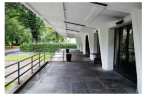
BALDAKIN: Den utkragede baldakinen i hele fronten ut mot Slottsparken og det sentrale trappemotivet setter sitt preg på bygget, sier jurymedlem Hanne Bauck. Foto: Eirik Helland Urke
